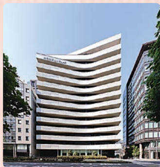
麹町弘済ビルディング (2025年6月竣工)
